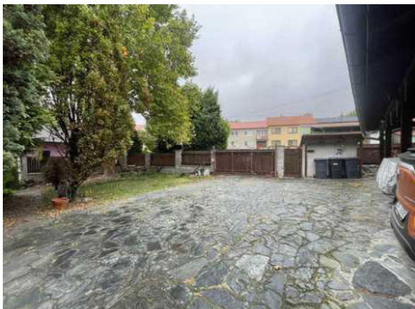
Zpevněná plocha před domem
